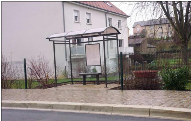
Les nouvelles recommandations imposent un quai d'embarquement surélevé avec des bordures hautes sur plus de 8 m de long pour l'accessibilité des Personnes à Mobilité Réduite (PMR) et un emplacement de 20 m pour stationner le bus en ligne droite (longueur du bus). Les deux arrêts ont été déplacés pour répondre à ces exigences de sécurité.
